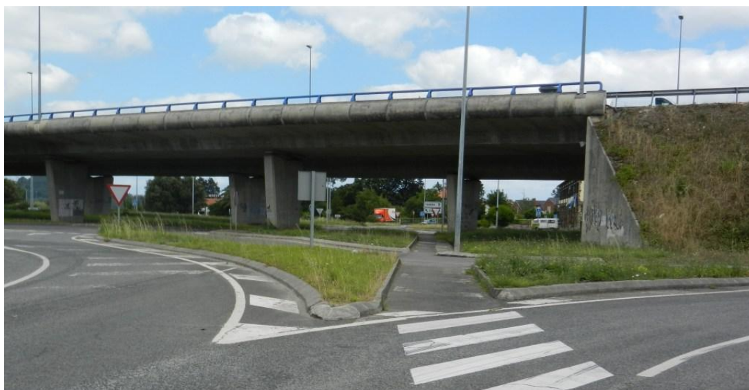
Fotografía 5. Paso inferior de la A-67
