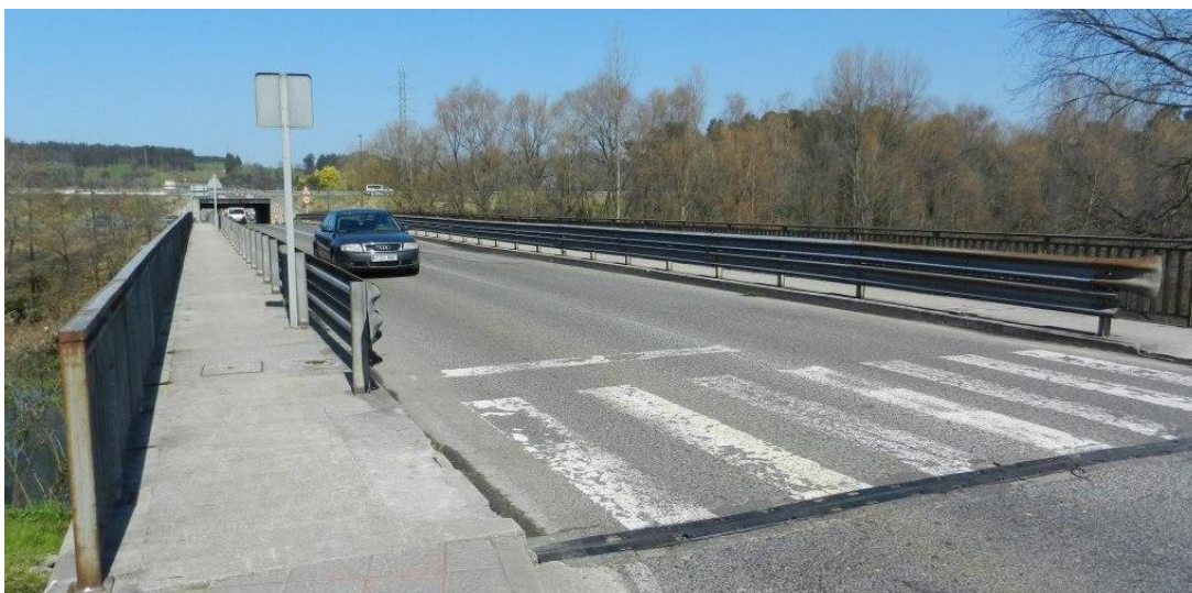
Fotografía 2. Puente sobre el río Saja en la carretera de SNIACE
