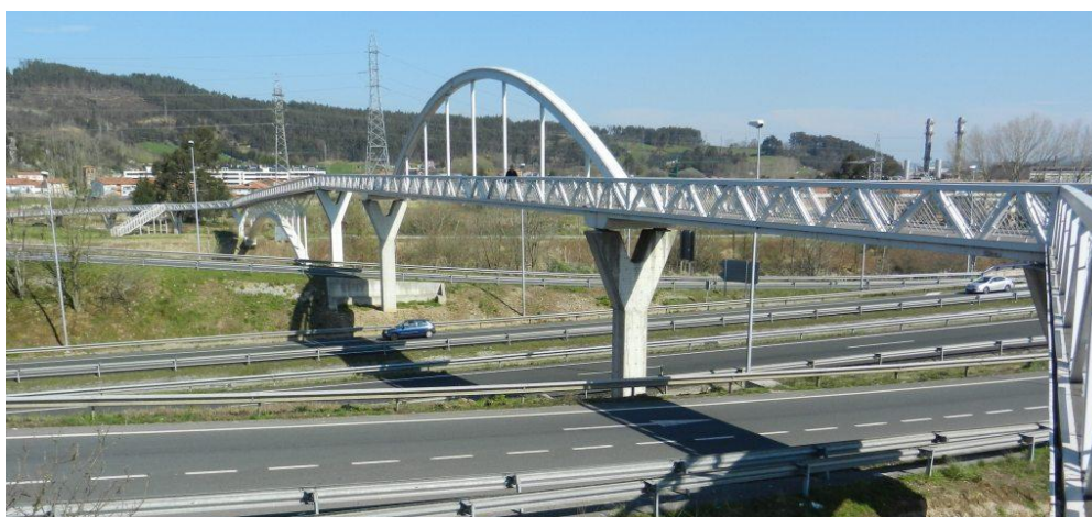
Fotografía 1. Inicio de la pasarela peatonal / ciclista de la Unión
