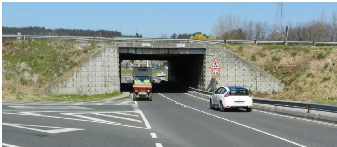
Fotografía 4. Paso inferior de la carretera de SNIACE bajo la A-8
