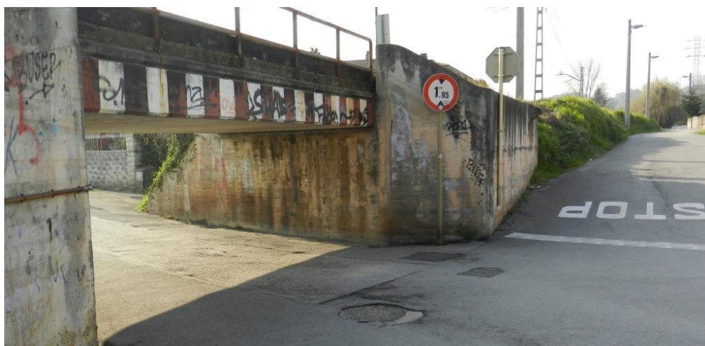
Fotografía 6. Paso inferior bajo el ferrocarril de ADIF Red de Ancho Métrico en Alcantarillas
